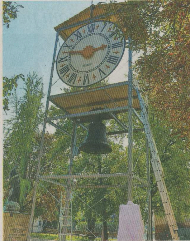
L'orologio ricostruito esattamente come quello distrutto, è su una torre di 9 metri
